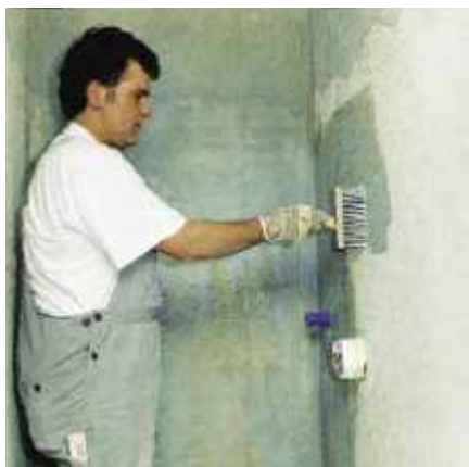
Površino predhodno premažemo z ustreznim temeljnim premazom.
