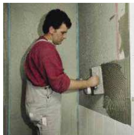
Lepjenje keramičnih ploščic s fleksibilnim PCI lepilom.
