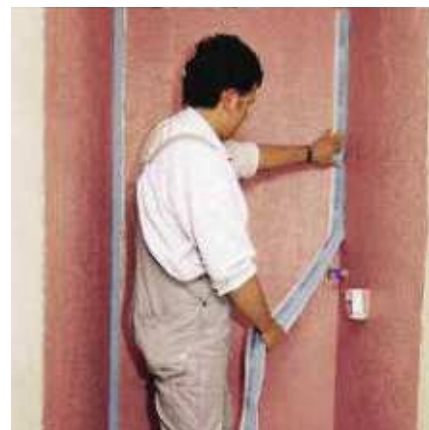
V spoje tla-zid in zid-zid vgradimo gumjasti trak PCI Pecitape Objekt .
