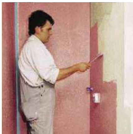
Prvi sloj PCI Lastoguma nanese s valjčkom.
