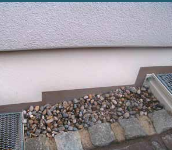
Kot izolacija cokla fasade
