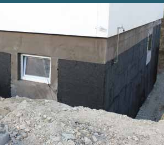
Kot izolacija cokla in vezni sloj pred bitumensko hladno hidroizolacijo
